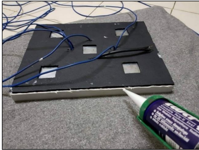
ภาพที่ 63 ลักษณะการติดแผ่นอลูมิเนียม และฉนวนกันความร้อน
