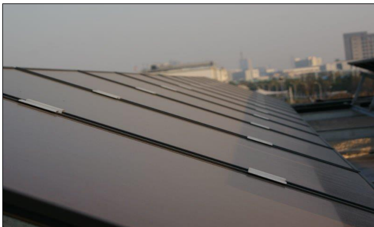
รูปที่ 4 เซลล์แสงอาทิตย์แบบอะมอร์ฟัส [8]
