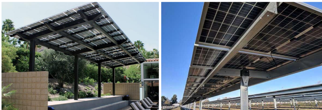
(ก) การติดตั้งในพื้นที่อยู่อาศัย
