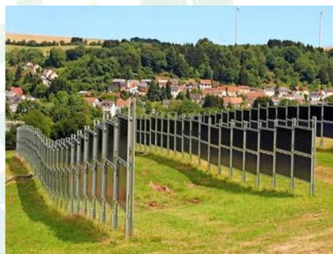
(ข) การติดตั้งแผงในแนวตั้งฉากแบบโรงไฟฟ้า
