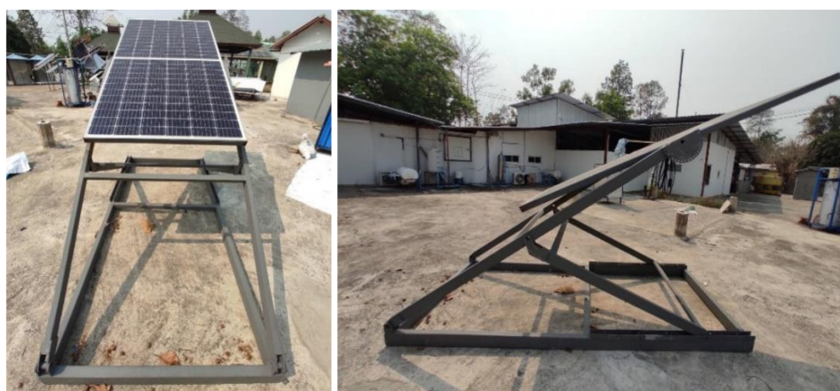
ภาพที่ 25 การติดตั้งบนโครงสร้างเหล็ก
