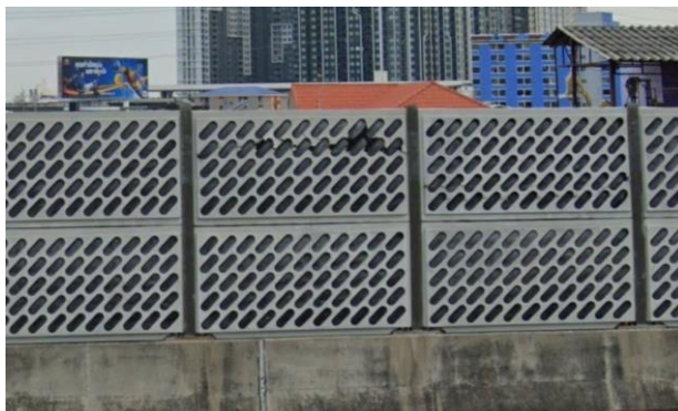
ภาพที่ 30 ความเสียหายบนทางพิเศษของกำแพงกั้นเสียง
