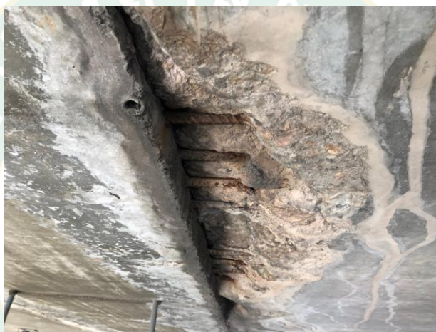
ภาพที่ 29 ความเสียหายบนทางพิเศษของกำแพงกันตก
