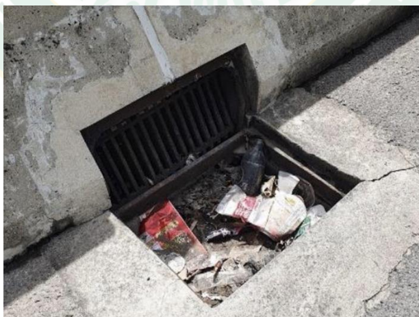
ภาพที่ 31 ความเสียหายบนทางพิเศษของระบบระบายน้ำ
