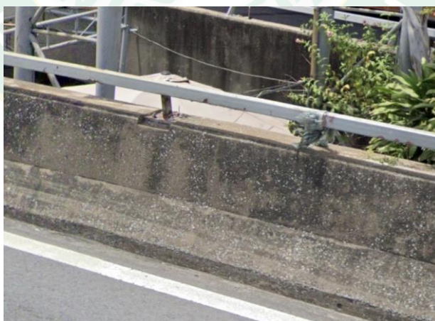
ภาพที่ 32 ความเสียหายบนทางพิเศษของราวเหล็ก
