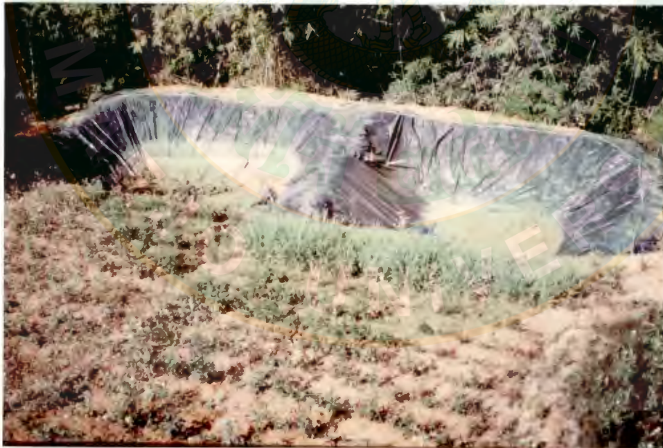
รูปที่ 5 บ่อตักตะกอนดินและปริมาณตะกอนดินที่ถูกกักขังการลงไปในบ่อตักตะกอน
