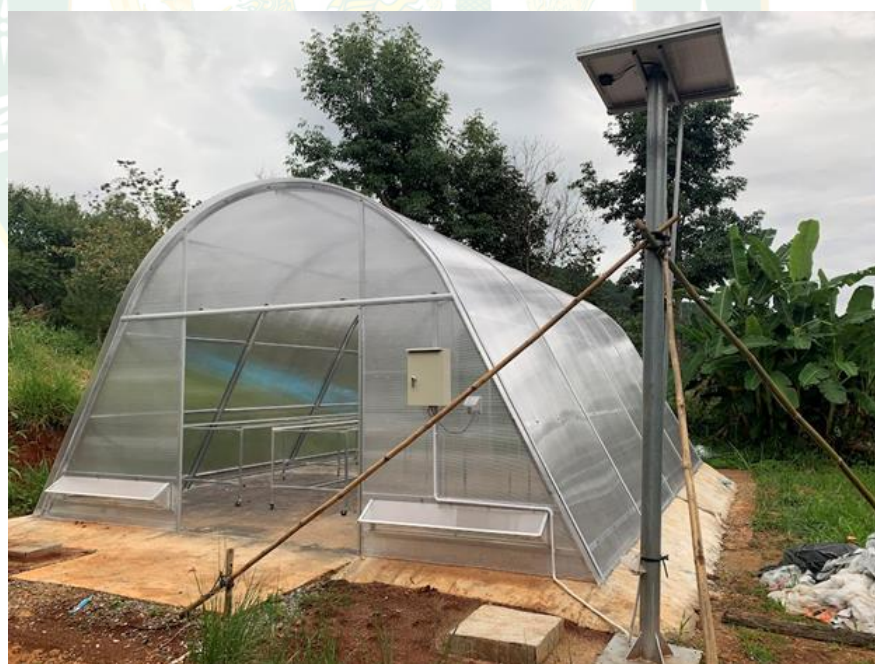
ภาพที่ 16 โรงเรือนอบแห้งพลังงานแสงอาทิตย์
