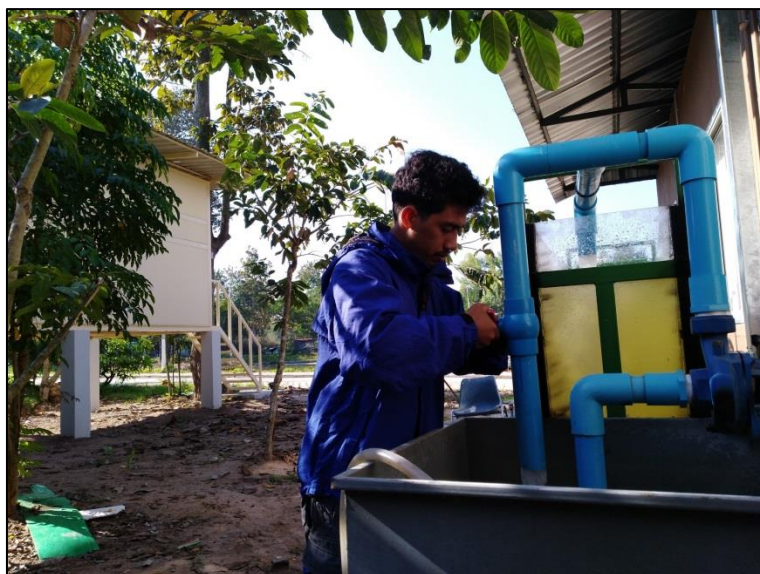
ภาพภาคผนวกที่ 16 ปรับการปล่อยน้ำเข้าสู่รางน้ำ
