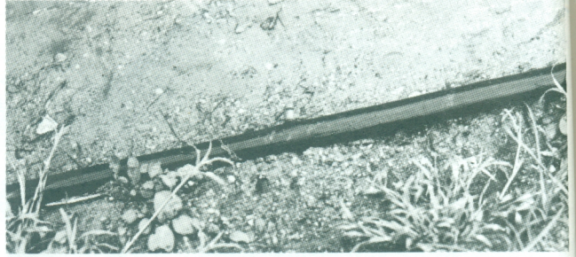
แสดงภาพหัวฉีดพ่นน้ำ ติดต่อกับท่อ PE สำหรับรดน้ำต้นไม้บริเวณเกาะกลางถนน เพื่อให้เกิดความเรียบร้อย ควรซ่อนสายท่อ PE ไว้ใต้พื้นดิน หรือบังด้วยพุ่มไม้
