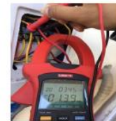
(ข) วัดค่ากำลังไฟฟ้าเครื่องปรับอากาศ
