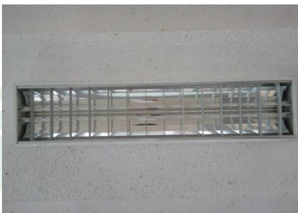
ภาพที่ 66 ลักษณะการใช้งานหลอดฟลูออเรสเซนต์ ชนิด T5 อาคาร 70 ปี แม่โจ้
