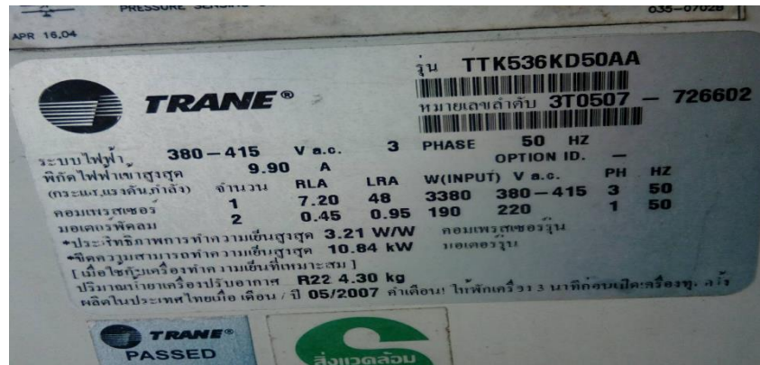
(ค) ลักษณะ Name Plate ของเครื่องปรับอากาศ
