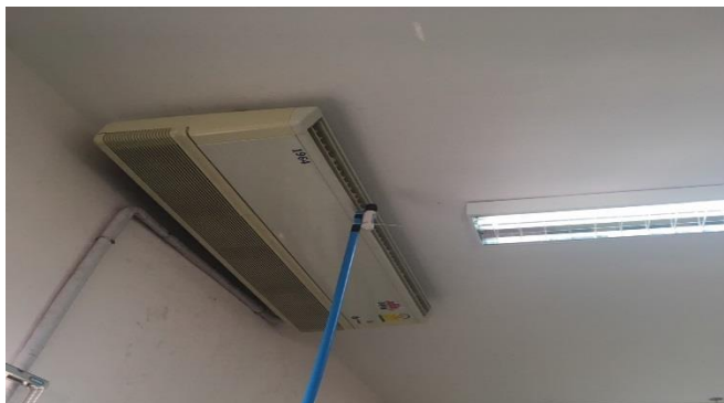
ภาพที่ 49 ตรวจสอบค่าอุณหภูมิ ความชื้นสัมพัทธ์ และความเร็วลม ช่องส่งลมเย็นและช่องลมกลับ
