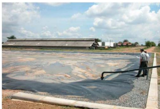
ภาพที่ 5 บ่อแบบพลาสติกคลุมบ่อดิน
