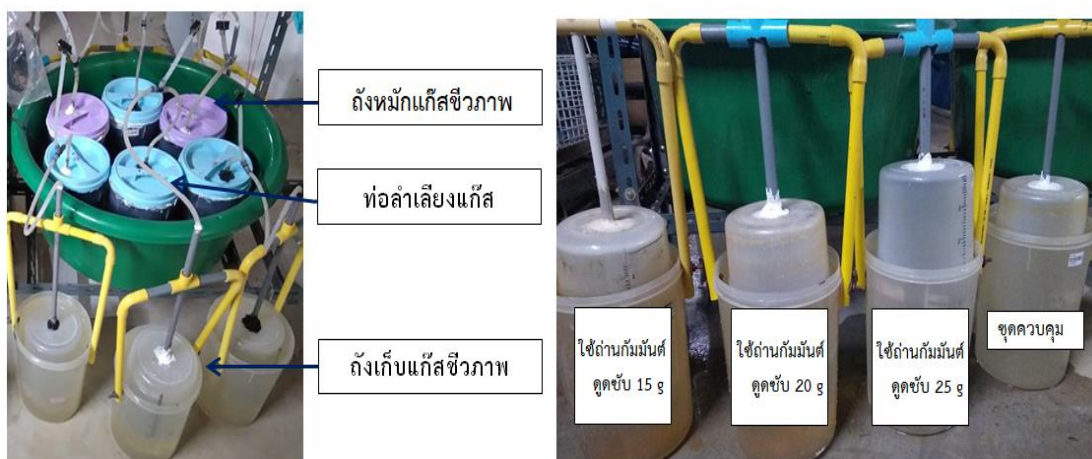
ภาพที่ 38 ลักษณะการวางถังหมักและถังเก็บแก๊สชีวภาพ
