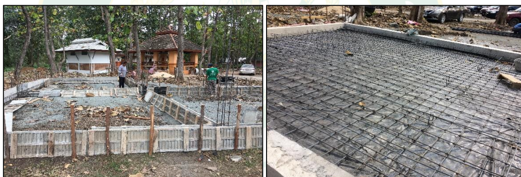
ภาพที่ 32 โครงสร้างฐานของโรงเรียน
