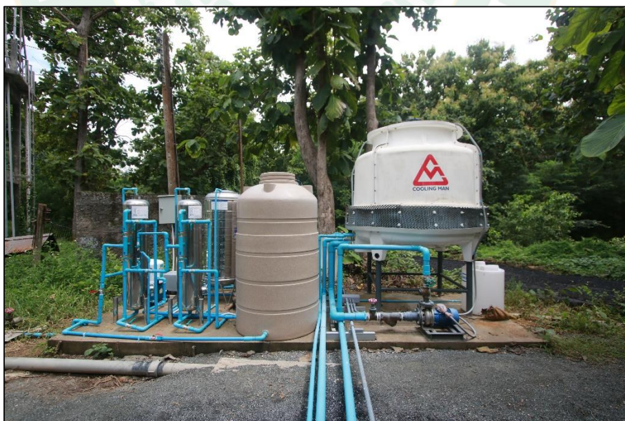
ภาพที่ 28 ระบบกรองน้ำสะอาดและหอผึ่งระบายความร้อน
