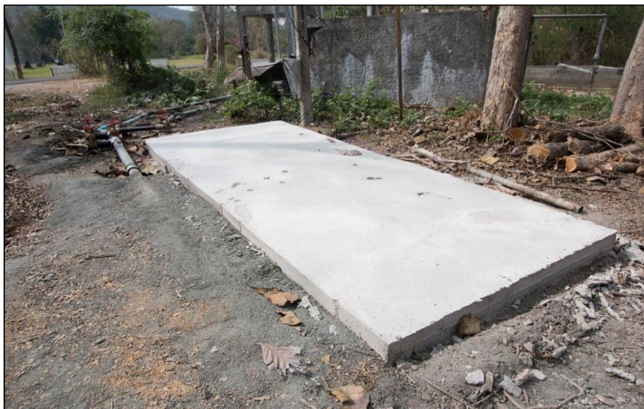
ภาพที่ 36 ฐานวางระบบระบายความร้อนและระบบน้ำสะอาด
