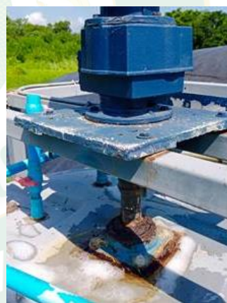
(ก) การเชื่อมมอเตอร์เข้ากับคาน (ข) การติดตั้งชุดมอเตอร์กวนผสมเข้ากับถังปฏิกรณ์
