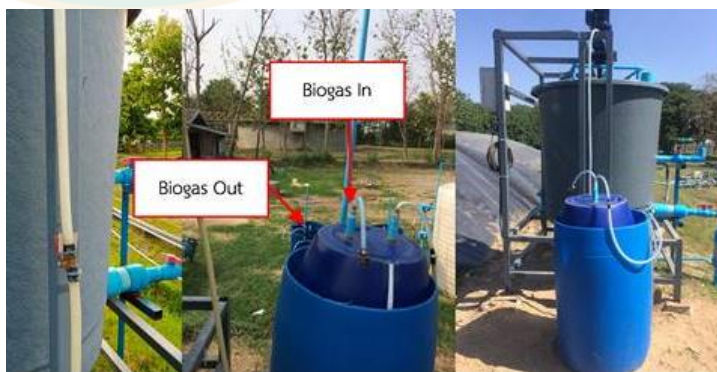
(ข) ท่อลำเลียงก๊าซชีวภาพจากถังปฏิกรณ์สู่ถังเก็บก๊าซชีวภาพ
