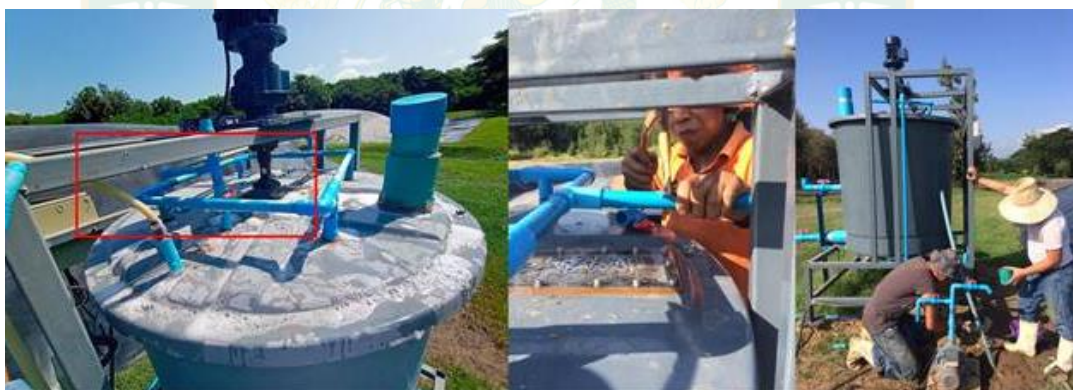
ภาพภาคผนวกที่ 14 การติดตั้งระบบหมุนเวียนตะกอนเข้ากับถังปฏิกรณ์
