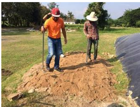
(ก) การเตรียมพื้นที่วางฐานรองรับน้ำหนัก
