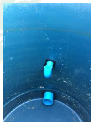
(ค) การนำท่อมาเชื่อมกับถัง
