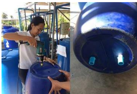
(ก) การเจาะรูบริเวณก้นถัง
