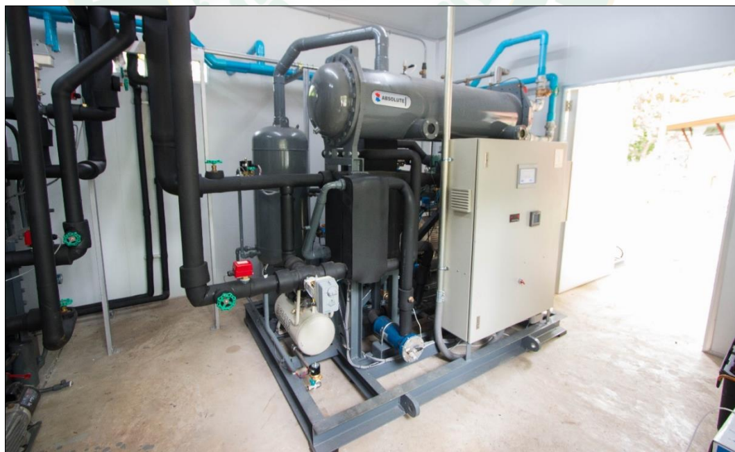
ภาพที่ 33 ระบบผลิตไฟฟ้าด้วยวัฏจักรแรงดันอินทรีย์ขนาดการติดตั้งประมาณ 10 \text{ kW}_e
