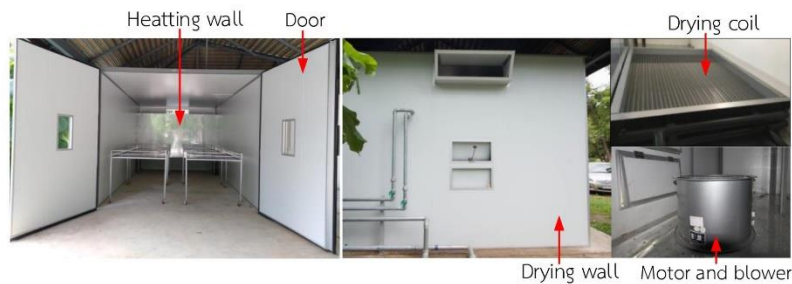
Figure 9 ห้องอบแห้งแบบรวมศูนย์ขนาดการผลิตพลังงานความร้อน 20 kW
