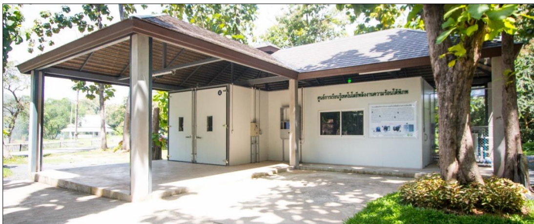
ภาพที่ 30 ลักษณะโรงเรือนของระบบผลิตพลังงานร่วมเมื่อสร้างเสร็จ
