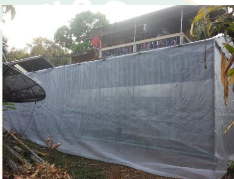
ภาพที่ 14 ลักษณะภายนอกโรงเรือนที่ล้อมสูง 3.5 เมตร ด้วยตาข่ายมุ้ง
