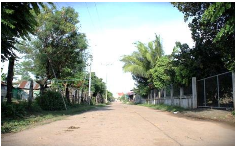
ภาพผนวกที่ 3 ถนนคอนกรีตในหมู่บ้านที่ชาวบ้านใช้สัญจร
