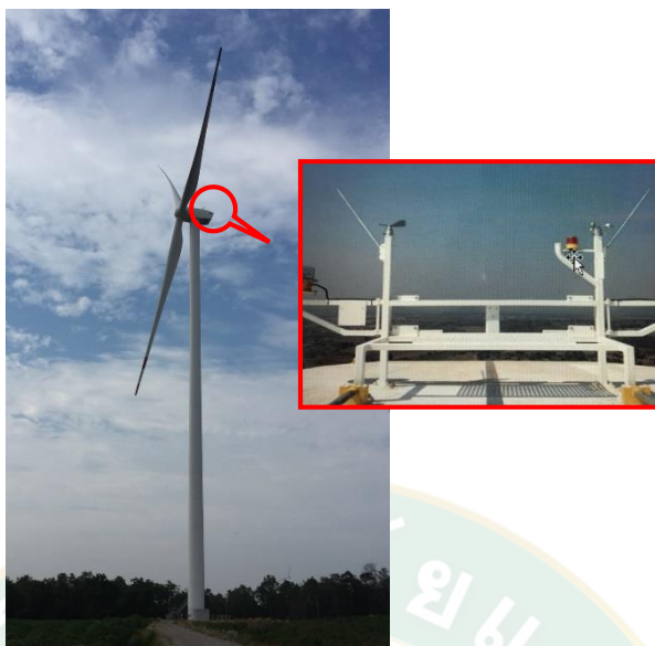
ภาพที่ 28 กังหันลมขนาดกำลังการผลิต 2.5 เมกะวัตต์ และอุปกรณ์วัดลมบนกังหันลม
