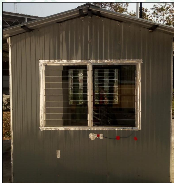
รูปที่ 51 การติดตั้งหน้าต่างบานเกล็ดในอาคารทดลองติดตั้งทางทิศเหนือ
