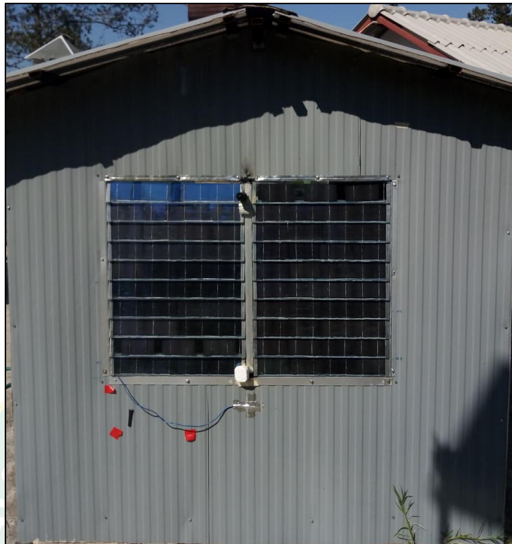
(ค) หน้าต่างบานเกล็ดเซลล์แสงอาทิตย์ บ้านเกล็ด 3 รูปที่ 50 การติดตั้งหน้าต่างบานเกล็ดเซลล์แสงอาทิตย์ร่วมกับอาคารทั้ง 3 แผงติดตั้งทางทิศใต้
