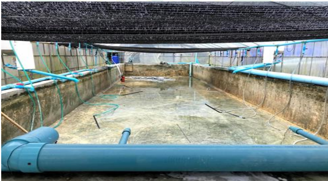
ภาคผนวกที่ 13 การจัดเตรียมท่อเลี้ยงปลากในระบบน้ำหมุนเวียน
