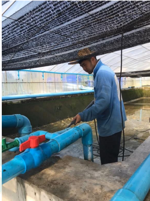
ภาคผนวกที่ 12 ทำความสะอาดท่อเลี้ยงปลากะพงขาวในระบบน้ำหมุนเวียน
