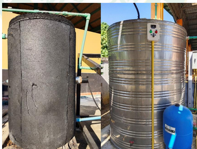
(ก) ถังเก็บน้ำร้อนขนาด 145 L (ข) ถังเก็บน้ำร้อนขนาด 2,500 L
