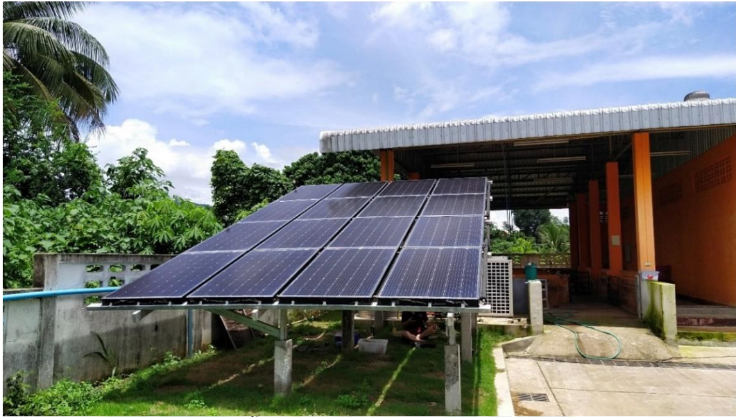
ภาพที่ 50 ผลการติดตั้งระบบ Solar PV/T Hybrid Assisted Heat Pump
