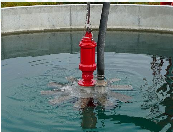
ภาพที่ 15 Submersible Aerator
