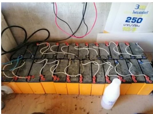
ภาพที่ 47 Battery ที่ทำการติดตั้งในบ่อเพาะเลี้ยงสัตว์น้ำแบบที่ 1
