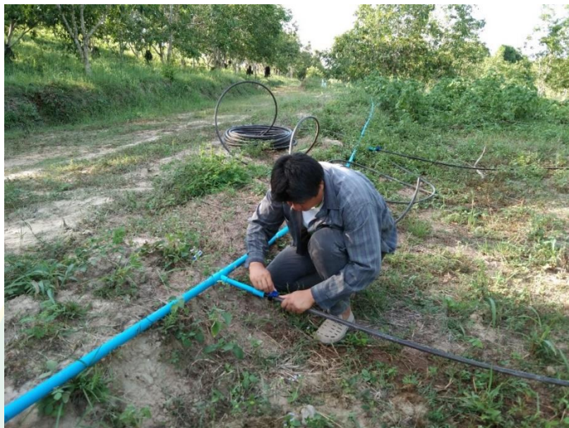
ภาพผนวกที่ 7 วางระบบน้ำแบบมินิสปริงเกอร์ ในพื้นที่แปลงวิจัย
